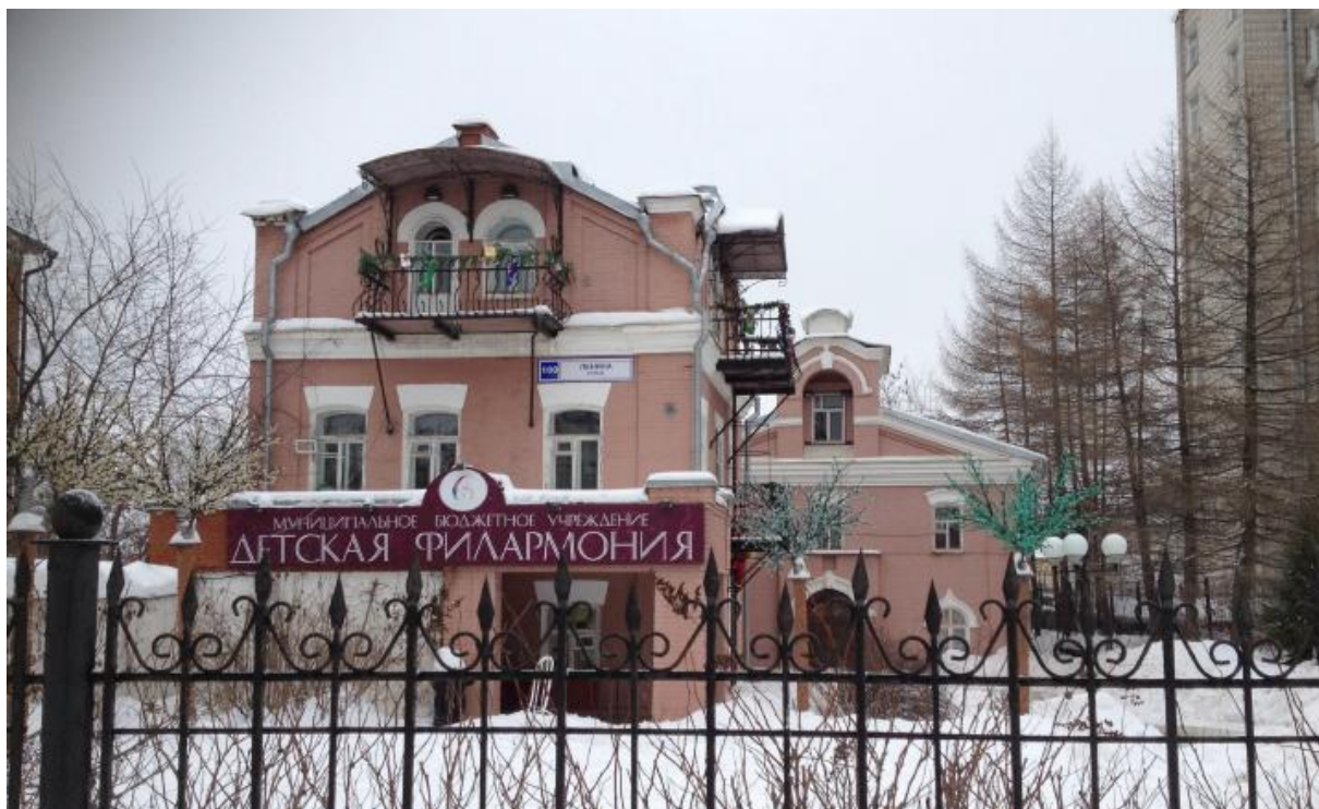
ул. Ленина, четная сторона, вид с запада на восток, западный фасад Объекта. Фото 03.01.2018 г.
