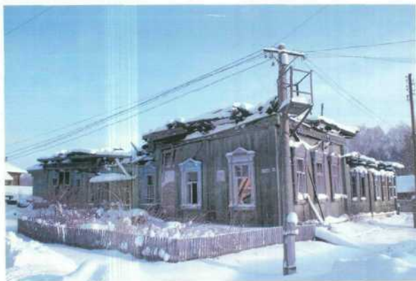
Фото № 3. Общий вид на объект культурного наследия. Южный и Восточный фасады. Повреждения объекта при пожаре. Фото: Пономарева О.Г. 05.02.2014.
