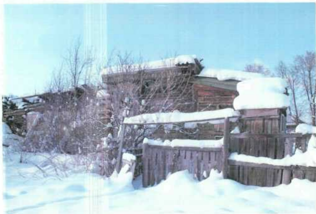
Фото № 9. Общий вид на объект культурного наследия. Северный фасад. Повреждения объекта при пожаре. Фото: Пономарева О.Г. 05.02.2014.
